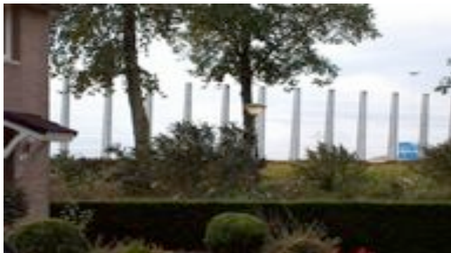
In de Blerickse wijk Vossener staan de huizen pal aan de geluidswal van de Zuiderbrug-A73. De schermen moeten 8 meter hoog worden om A74-geluidshinder tegen te gaan...
