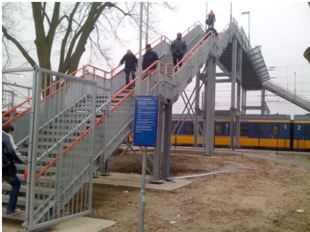
De steile en hoge loopbrug over het spoor en de perrons
